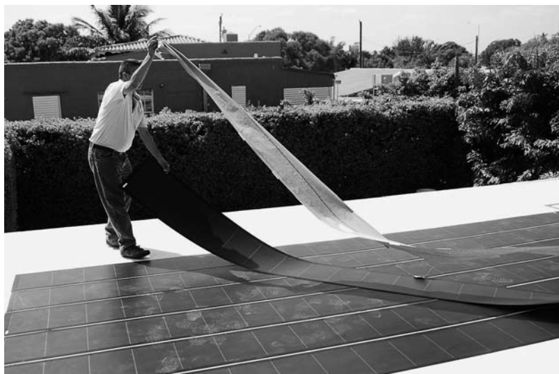
Rysunek 1.1. Instalacja cienko-warstwowych ogniw polimerowych wykonanych techniką nakładania szczelnego metodą ze zwoju na zwój, wyprodukowanych w Krajowym Laboratorium OakRidge (ORNL) w Stanach Zjednoczonych. Zdjęcie: Ken Fields
